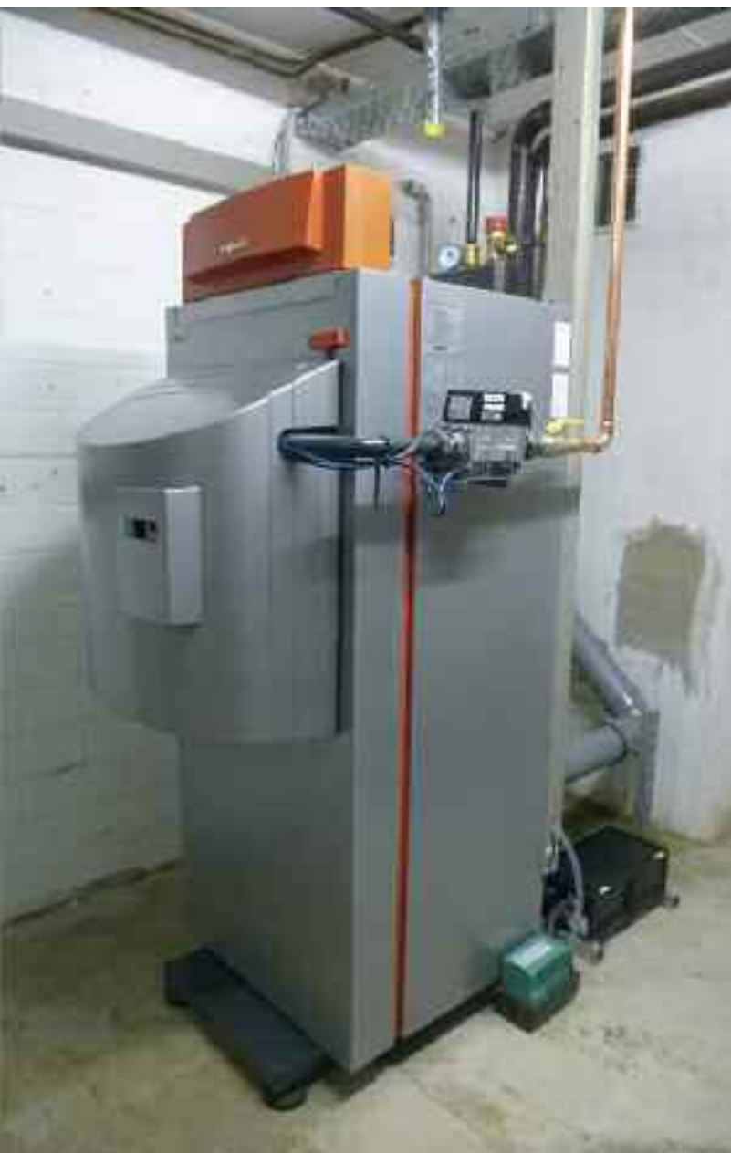
Neue Heizungsanlage am Standort Siegelssknippen
