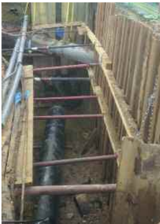
Erneuerung der Leitung DN 600 Bonn-Gronau
