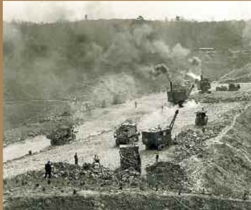
Schütтарbeiten am Absperrbauwerk mit Dampfbaggern und Großraumkippfahrzeugen.
