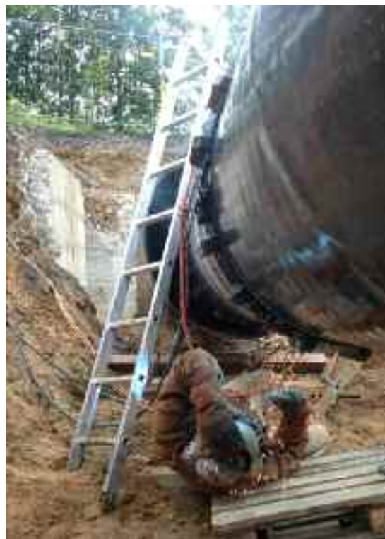
Schweißarbeiten an der III. Hauptversorgungsleitung
