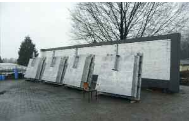
Probeaufbau im Werk vor Auslieferung
