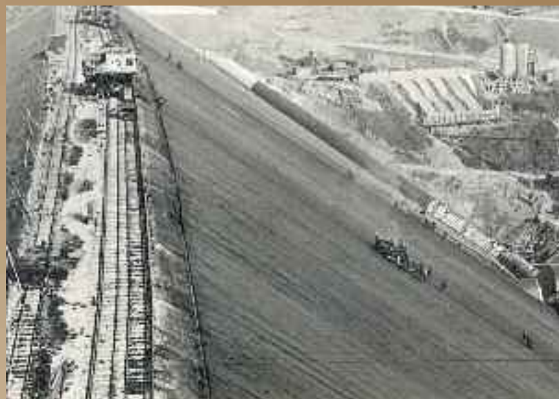
Blick von der Dammkrone beim Aufbringen der stauseeseitigen Asphaltbetondichtung mit dem Kreuzungsbauwerk von Herdmauerkontrollstollen und Grundablaßstollen.
