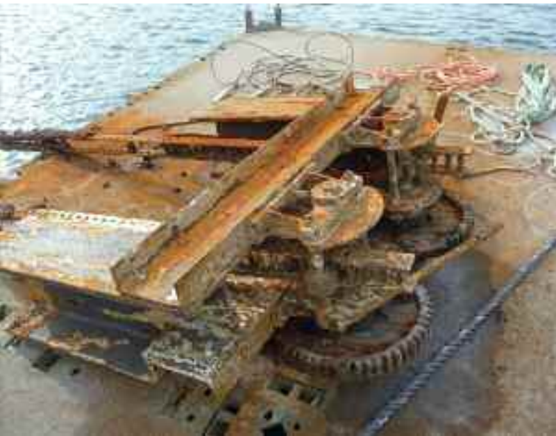
Abgebautes Windwerk der bauzeitlichen Wahnbachdurchleitung
