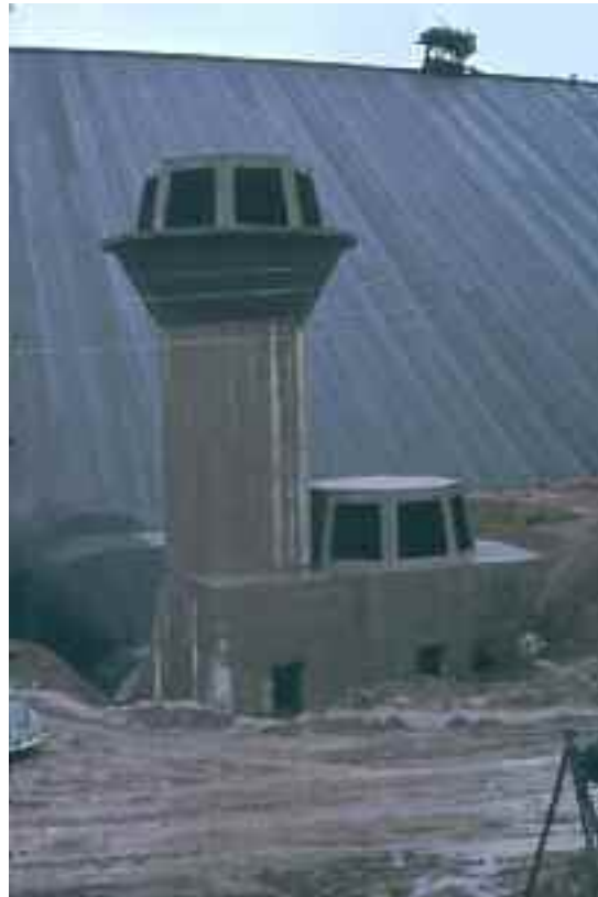
Grundablasselinläufe während der Bauzeit 1956
