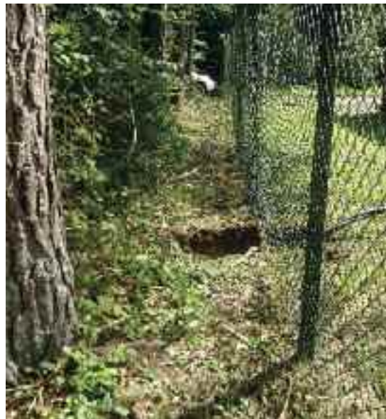
Kabelgraben Pumpwerk Honscheid
