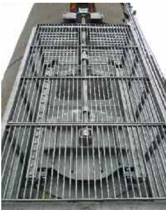
Verschlusschieber und Rechen am Entnahmeturm
