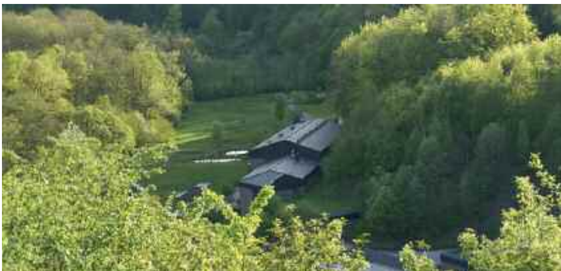
Luftbild Betriebsgelände Pumpwerk Seligenthal
