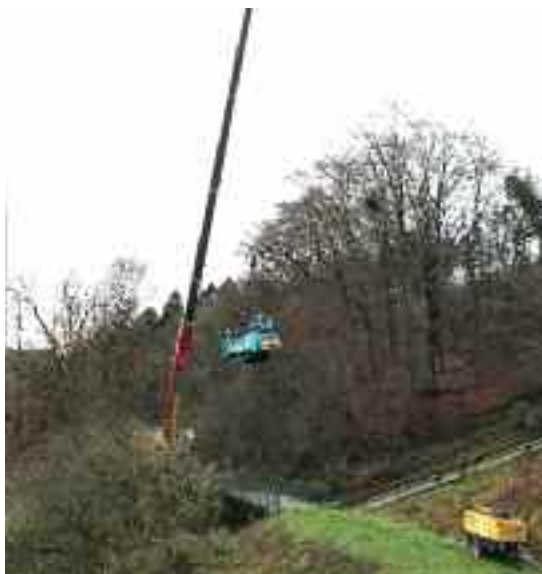
Kraneinsatz, um das 8-Tonnen-Bohrgerät auf die Berme zu bringen.
