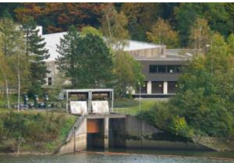
Vorsperre mit Einlaufbauwerk und Filterhalle der Phosphor-Eliminierungsanlage
