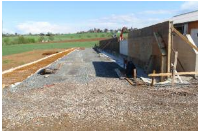
Fahrsiloanlage im Bau
