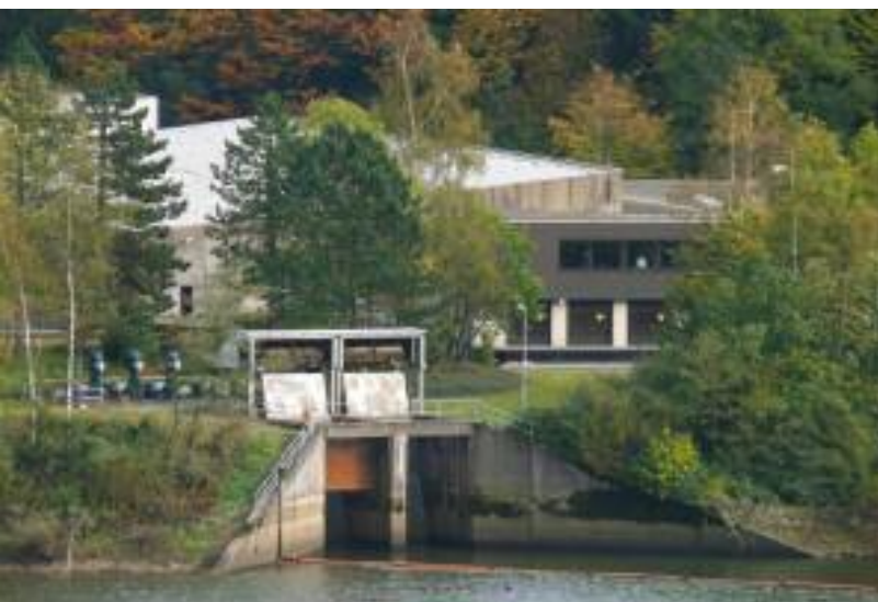
Vorsperre mit Einlaufbauwerk und Filterhalle der Phosphor-Eliminierungsanlage
